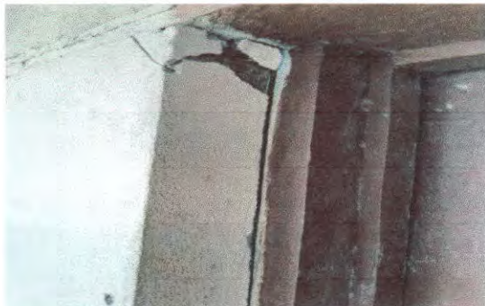
Foto 1: Sustrucción de Puerta de madera por metal
