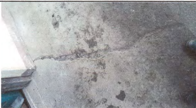
Foto 3: Sustrucion de piso de trota de concreto
