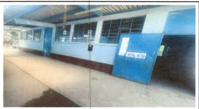
Foto 4: Pintura de paredes de la escuela
