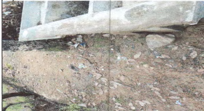
Foto 2: instalación de tubería y de pila
