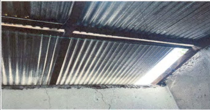
Foto 1: Sustrucion de techo de madera por metal y lamina troquelada
