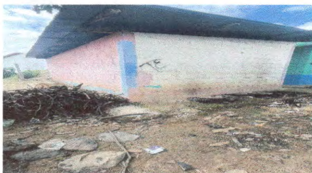
Foto 3: Mantenimiento y reestructuración de estufa rural
