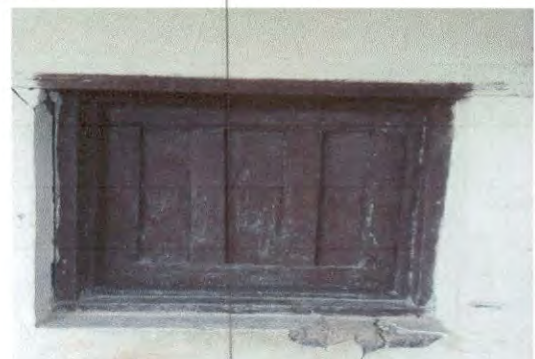
Foto 2: Cambio de ventana de madera por metal
